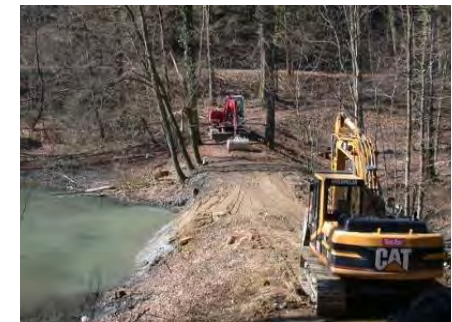
Dammsanierung beim Drittweier im Jahr 2005
