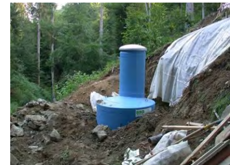
Neubau Brunnenstube im Bärelloch, Ausgangspunkt für den Wasserstollen
