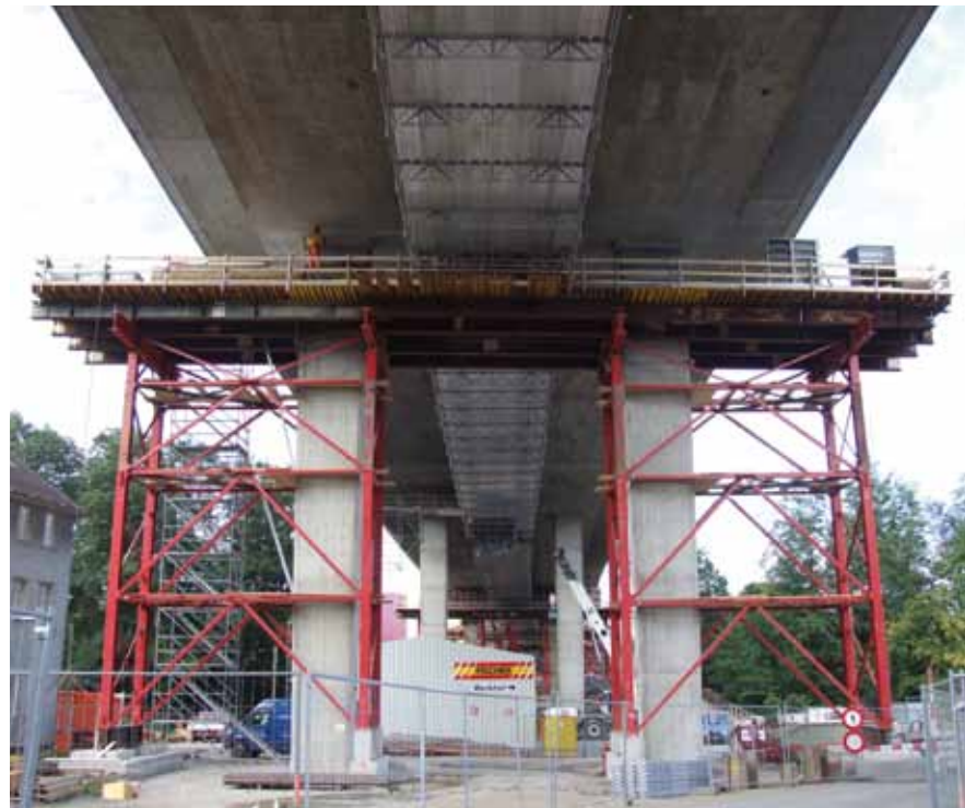
Arbeitsgerüst am Aabachviadukt im September 2010
