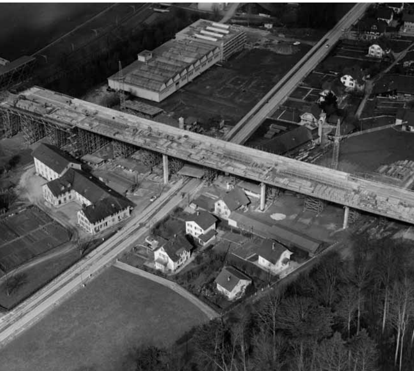
Der Aabachviadukt im Bau, 1963
