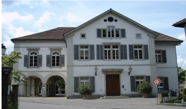
Alter Gemeindesaal Eingang / hinterer Eingang Säulenhalle
